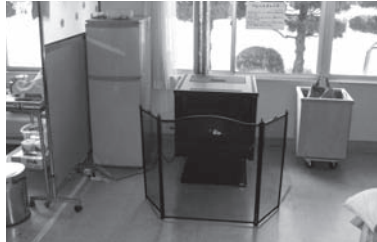
佐良山小学校保健室に設置されているペレットストーブ
