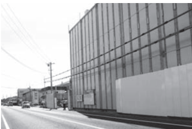
南部污水幹線の工事現場
