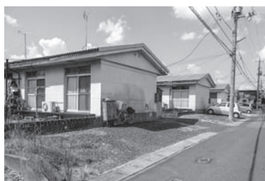
老朽化が進む市営住宅
