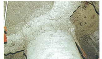
鉄骨耐火被覆
