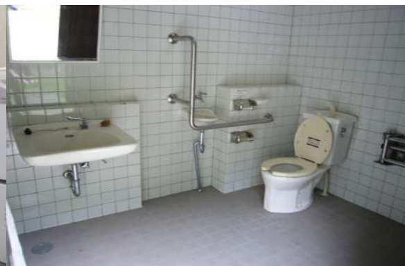
改修前の車椅子用便所
