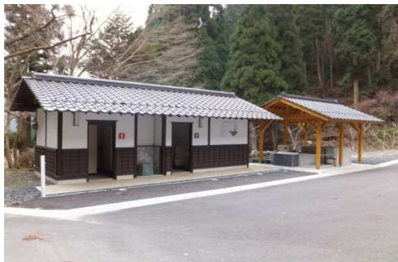
観光トイレとバイオマス浄化槽
