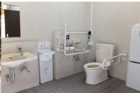
改修後の多目的便所
