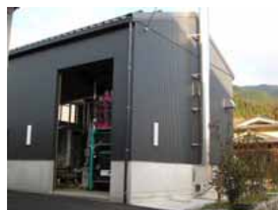
チップボイラーと機庫
