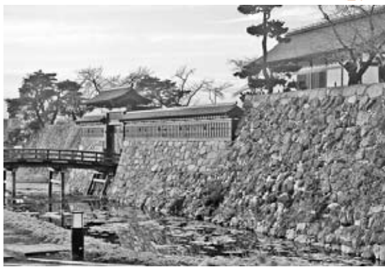
▲復元整備された松代城風景写真
