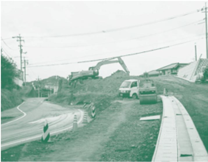
林田の工事現場
