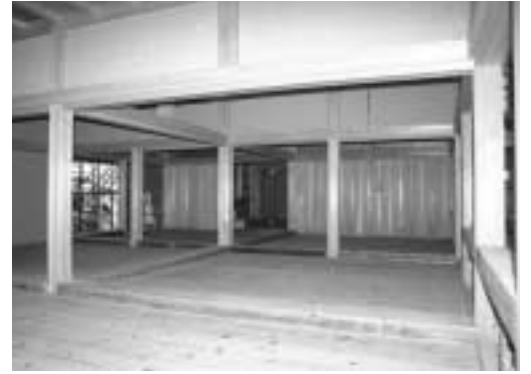
写真2 施工中の備中櫓内部の様子
