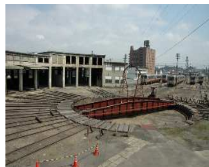
【J R 津山駅機関車庫・転車台】
