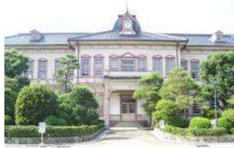
【岡山県立津山高等学校本館】
