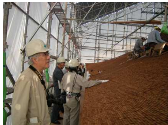
【中山神社本殿屋根修理工事】
