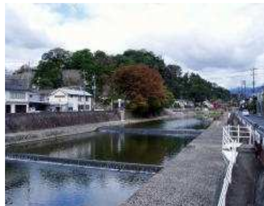
【津山城跡の樹木伐採・法面整備】
