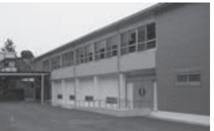
向陽小学校体育館
