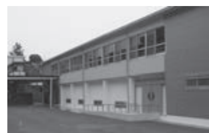
向陽小学校体育館
