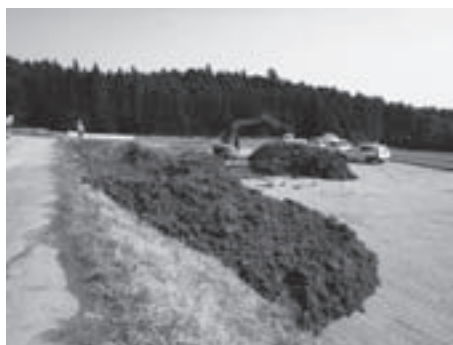
広戸池新設工事現場
