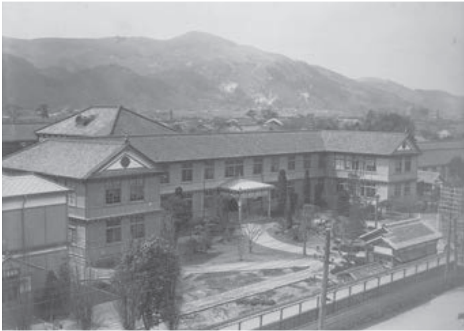
写真提供・江見写真館
