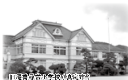
旧遷喬尋常小学校（真庭市）
