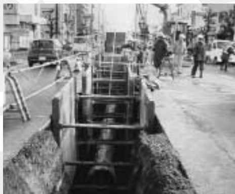
耐震管布設工事(小田中)
