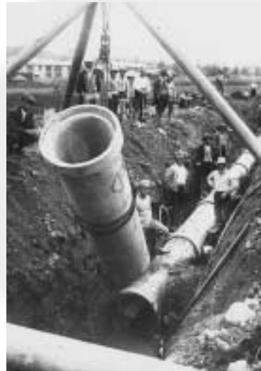
配管工事のようす(昭和8年)
