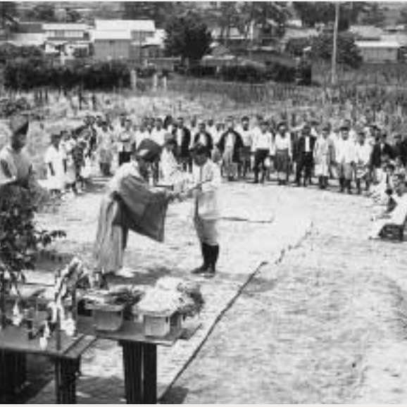
地鎮祭のようす(昭和7年)
