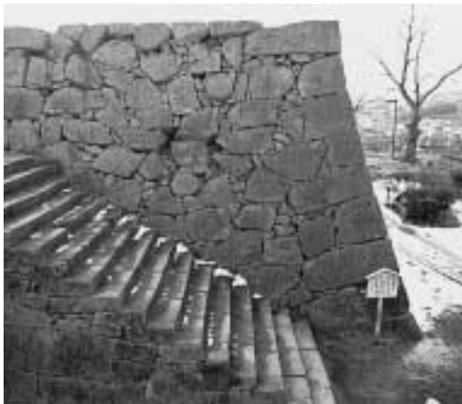
天守台北東隅角部（写真1）
