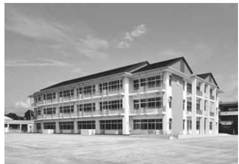
【耐震化事業で改修した津山市立東小学校】
