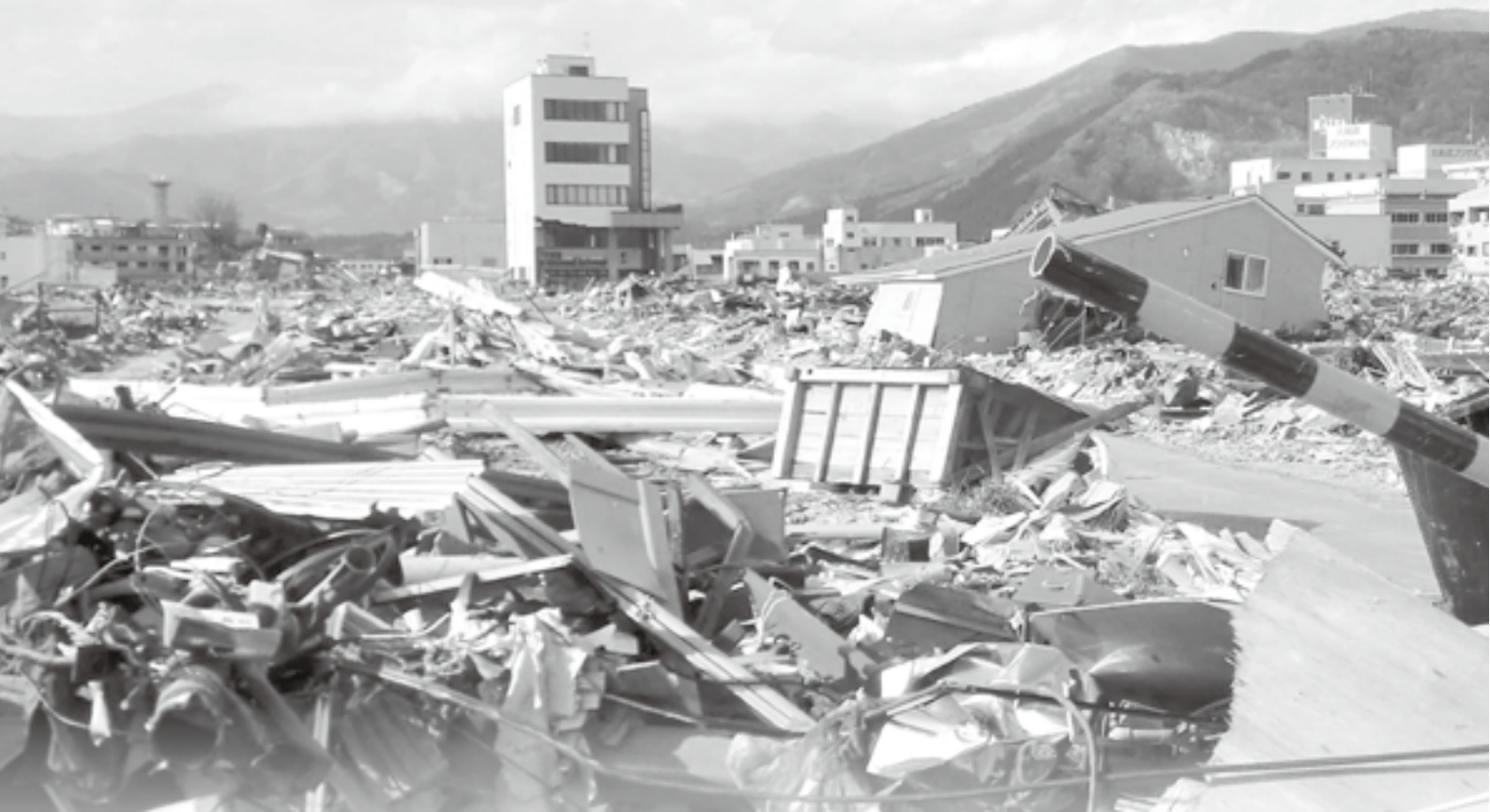
岩手県大船渡市の被災状況（5月4日）
