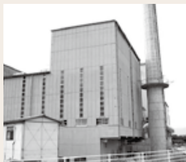
▲電気集塵機は建物の中二階にあります
