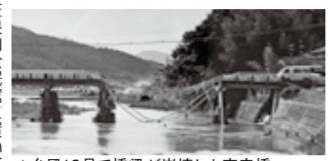
▲台風10号で橋梁が崩壊した宝来橋
