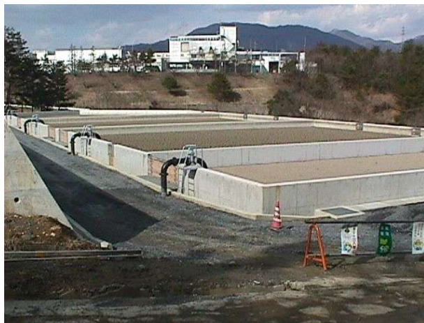
〔草加部浄水場 汚泥処理施設：天日乾燥床〕
