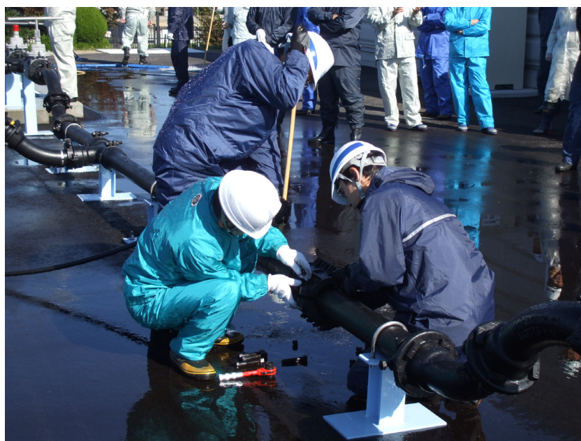
〔耐震管接続演習風景〕
