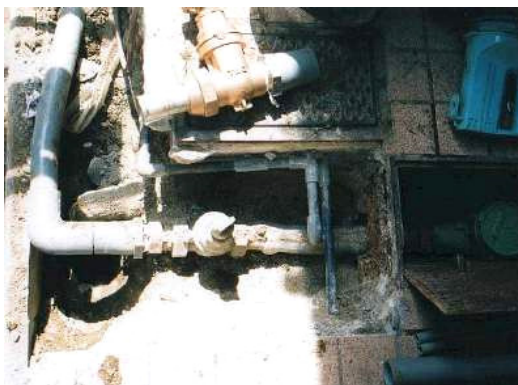
〔給水管に使われていた鉛管取替え工事〕
