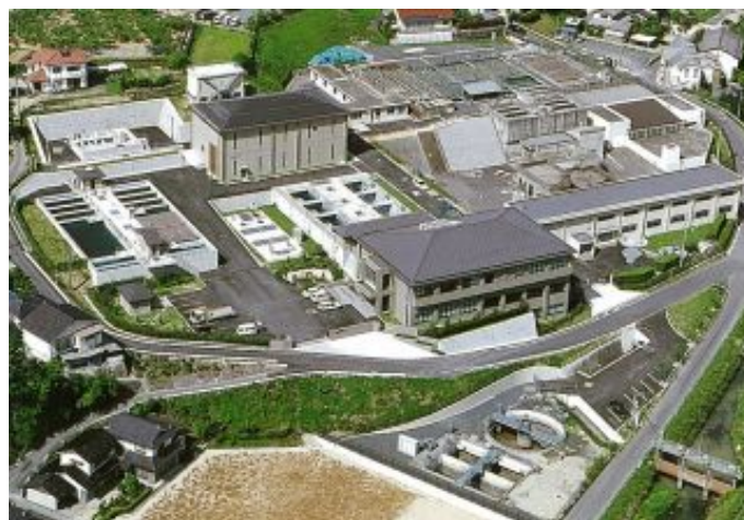
〔津山市水道局 小田中浄水場全景〕
