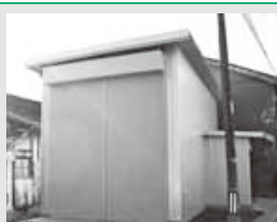
▲山車収納機庫の整備 (昭和町町内会)
