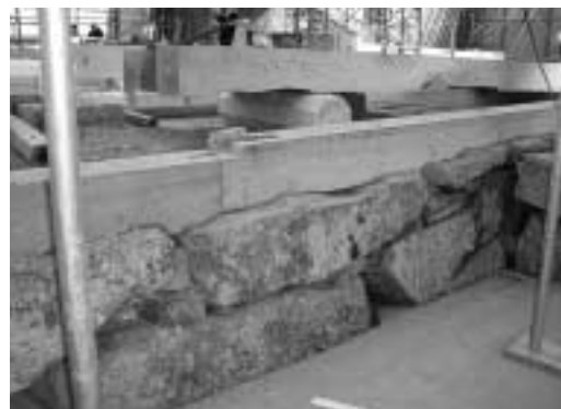
写真2 備中櫓土台据え付けの状況
