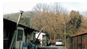
早期の修繕を望む久米地域の権現団地
