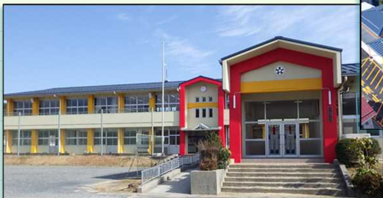
誠道小学校の改修後の外観
