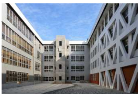
耐震補強工事が完了した津山東中学校
