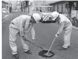
道路の補修をしている市職員
