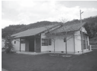
補助金を活用して照明をLED化した上横野会館
