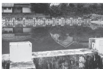
老朽化が進んだ久米中学校のプール
