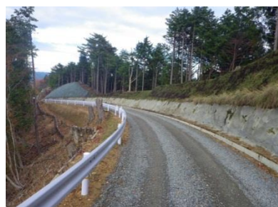
因美線開設状況(加茂町知和地内)
