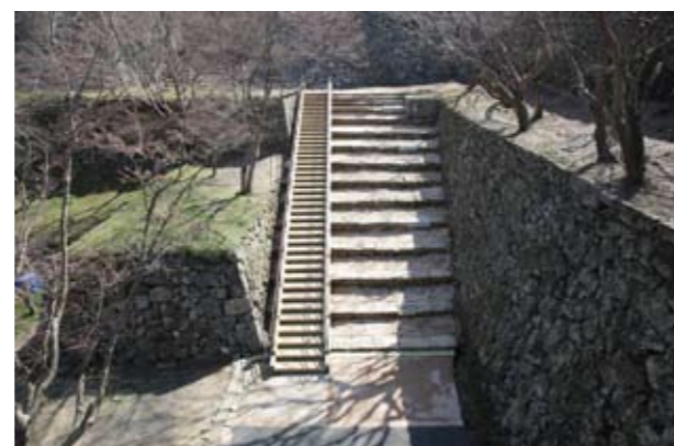
裏鉄門下雁木整備状況
