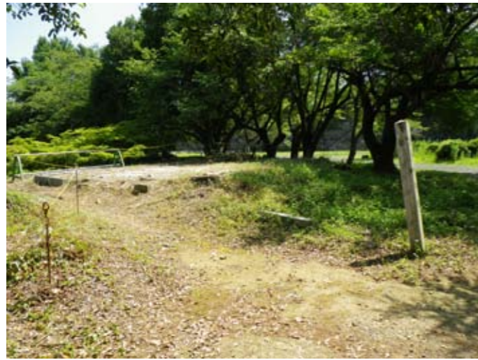
涼檜コンクリート基礎
