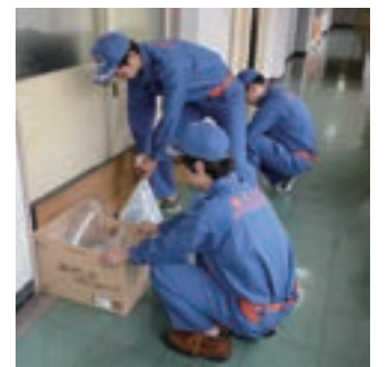
板を置き水のうで固定する
