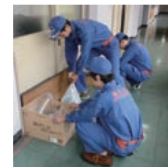
板を置き水のうで固定する
