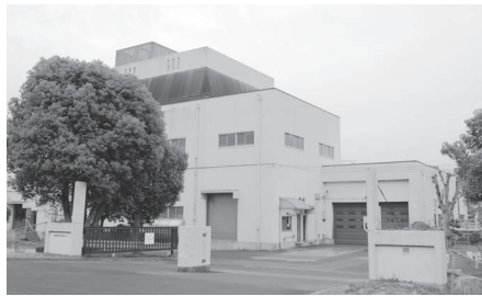
津山圏域衛生処理センター
