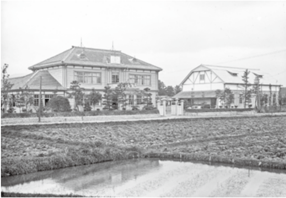
写真提供・江見写真館
