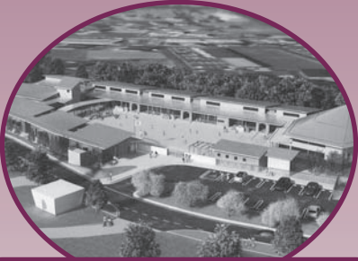
一宮保育所移転新築工事契約 6億1,074万円
