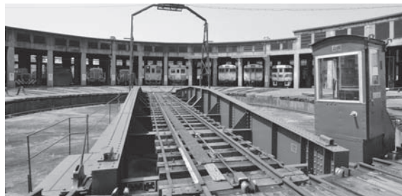
旧津山扇形機関車庫
