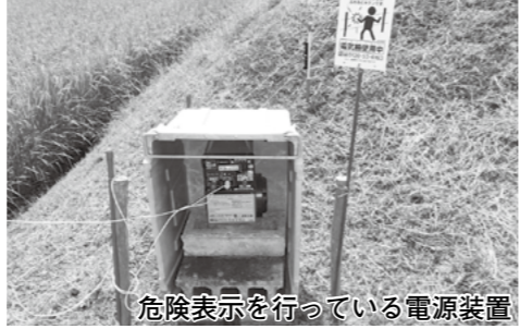
危険表示を行っている電源装置
