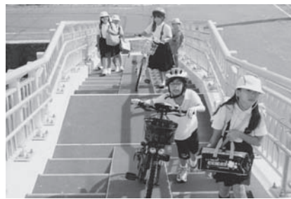
自転車道が整備された久米川南地区の歩道橋
