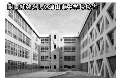
耐震補強をした津山東中学校校舎
