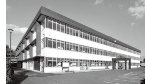
開放廊下を内廊下に改修した北陵中学校校舎
