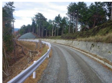
因美線開設状況(加茂町知和地内)
