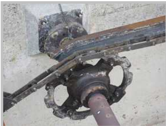
[沈殿池汚泥掻き寄せ設備の劣化状況]
