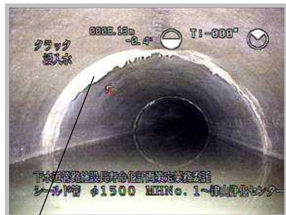
ひびわれからの浸入水
