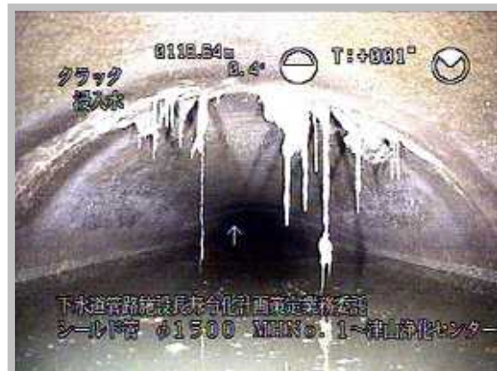
[幹線管渠内の劣化状況]
