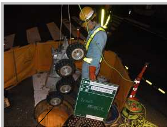
管きょ内部の調査の様子
