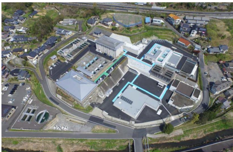
〔小田中浄水場〕
