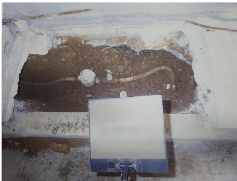
〔鉛製給水管の取替え工事〕
