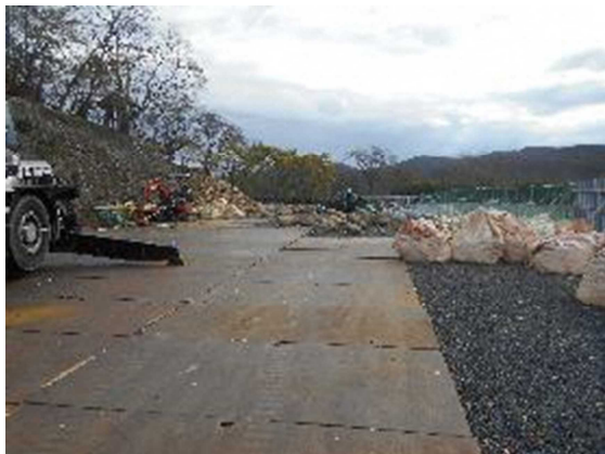
現場施工状況
