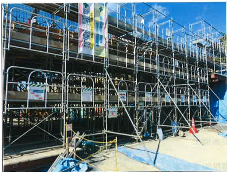
① PC橋梁・型枠支保工
