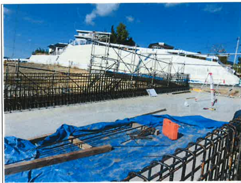
② PC橋梁 床版コンクリート打設状況
