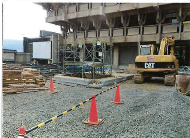
④ 東側エントランス増築
