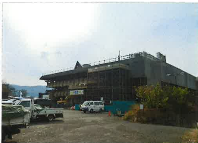
① 工事現場全景
