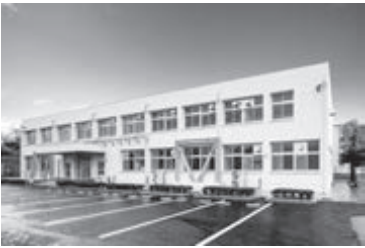
向陽小学校耐震化事業
