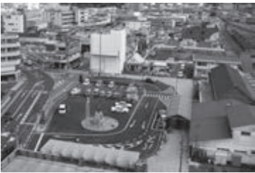
津山駅北口広場整備事業
