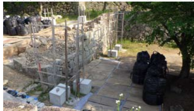
写真5 裏下門東側石垣解体状況（北西から）
