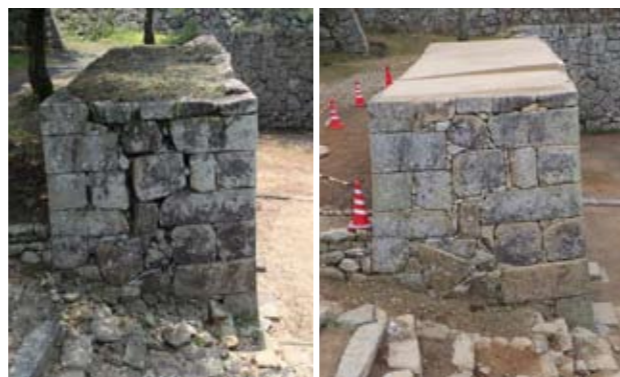
写真6 石垣北面修理前（左）と修理後（右）
