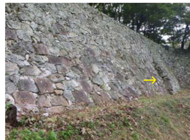
写真2 積み直した所と積み直していない所との境界にできた段差(黄色矢印)
