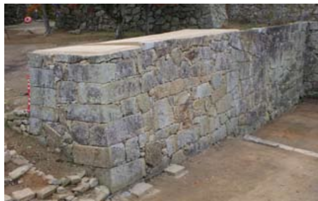
写真8 北西から（修理後）
