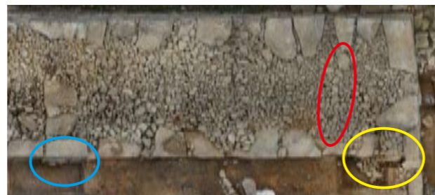
写真5 解体後の裏下門東側石垣のオルソ写真(右が北) 赤丸が石列。解体前の石列の真下に位置します。南東隅(青丸)と北東隅(黄丸)とは、石垣の基礎が異なることがわかります。
