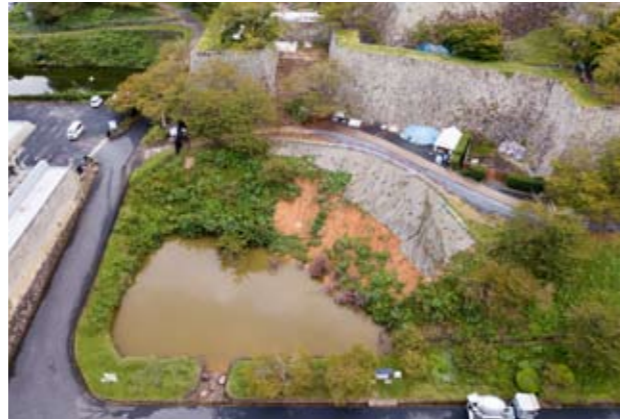
写真11 厩堀法面崩落後の厩堀航空写真(左が北)
