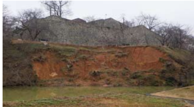
写真12 平成31年1月に撮影した厩堀法面(北西から)
