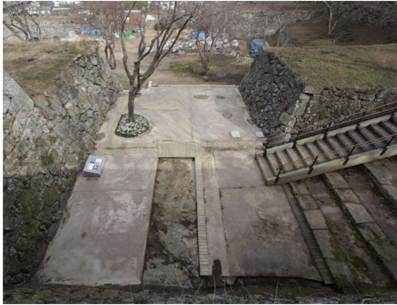
写真1 整備工事が完了した裏中門枅形(中央下は岩盤がみえるようにするため舗装をしていません)
