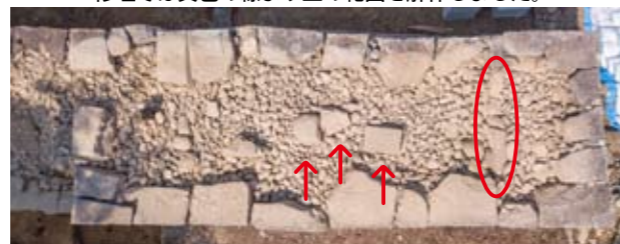
写真4 解体前の裏下門東側石垣の航空写真(右が北) 矢印の先にあるのが礎石。赤丸部分が石列。
